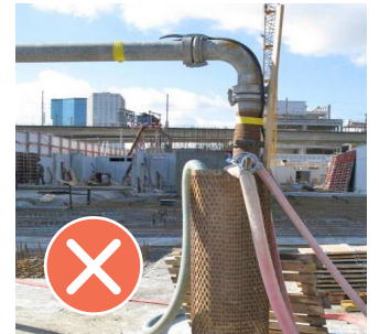
Keine Einleitung von Baugrubenabwasser ins Grundwasser!
