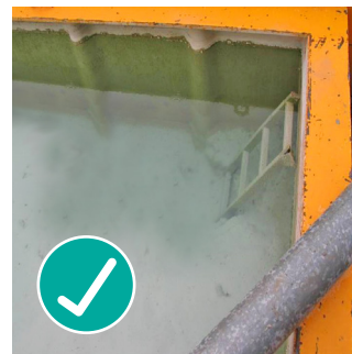
Becken mit guter Absetzwirkung
