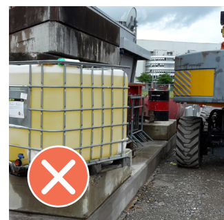
Auffangwanne fehlt, Abstand von Baumaschine zu gering
