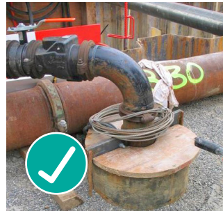
Abgedeckter Filterbrunnen
