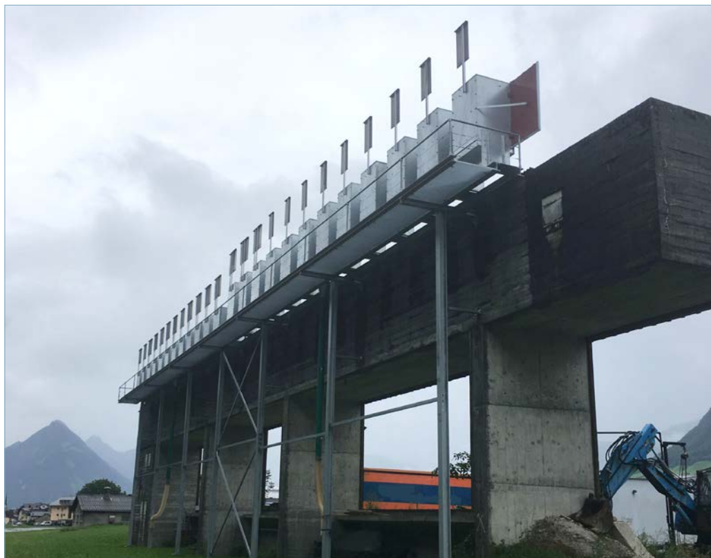
Künstliches Kugelfangsystem der Schiessanlage Herdern in Ennetbürgen (Ansicht von hinten). (Bild zvg)
