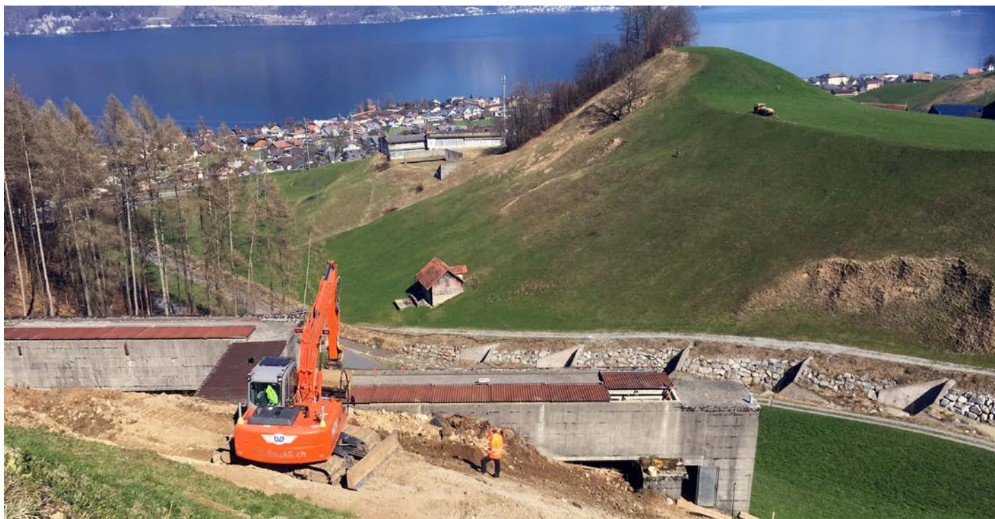
Schiessanlagenrenovierung Beckenried (Blickwinkel hinter Zeigerstand). (Bild zvfg)
