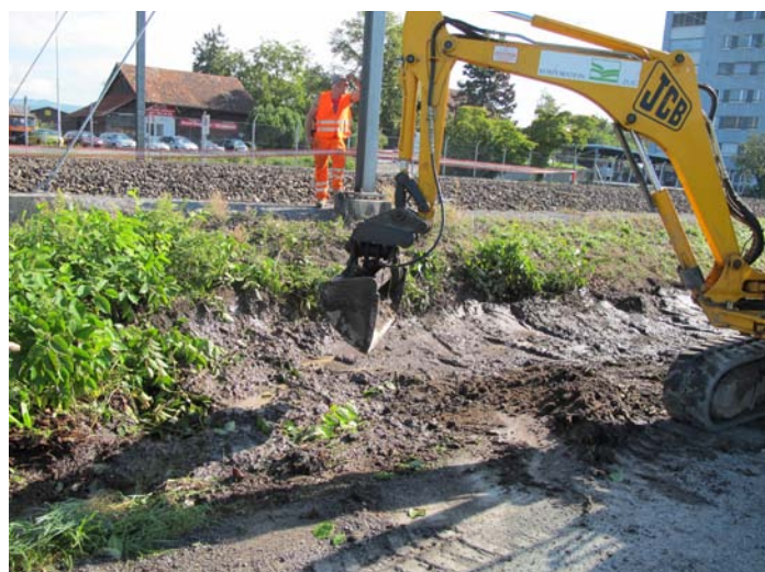
Ausbaggern von Japanischem Knöterich
