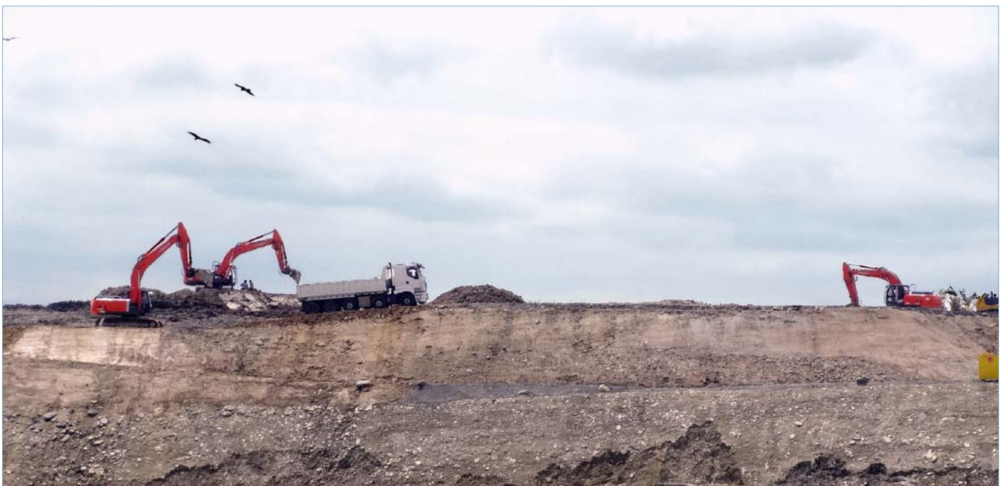
Auf einer Deponie Typ A (Bezeichnung gemäss VVEA) wird unverschmutztes Aushubmaterial abgelagert.
