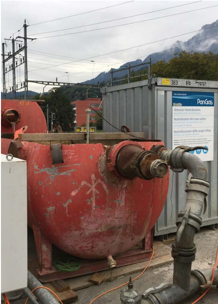
Baustellenentwässerung mit Absetzbecken und Neutralisation (Quelle: ZUBI)
